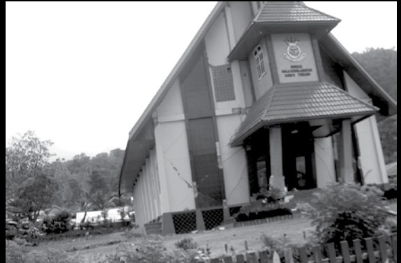
Gereja Bala Keselamatan Korps Tomado- Salah satu gereja di Kecamatan Lindu, Kabupaten Sigi, mengalami kerusakan yang sangat parah dan tidak bisa digunakan kembali pasca kejadian gempa Sigi (gempa Lindu) 6.2 SR.
